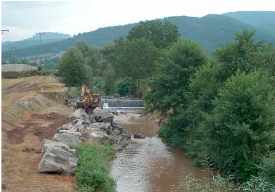
Abb. 7.4 Ahmattenwehres im Mündungsbereich des Erlenbachs in die Kinzig während des Umbaus
